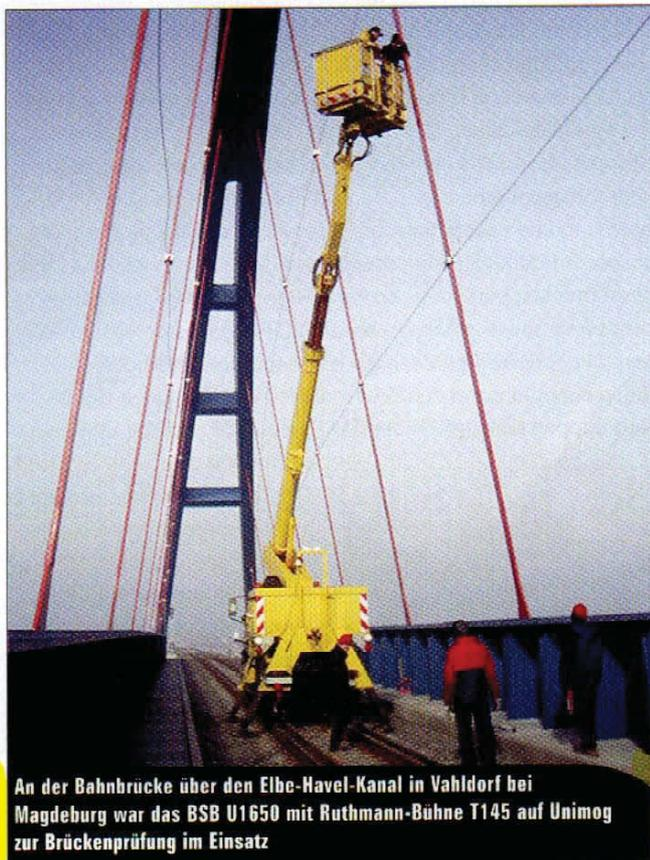
An der Bahnbrücke über den Elbe-Havel-Kanal in Vahldorf bei Magdeburg war das BSB U1650 mit Ruthmann-Bühne T145 auf Unimog zur Brückenprüfung im Einsatz
